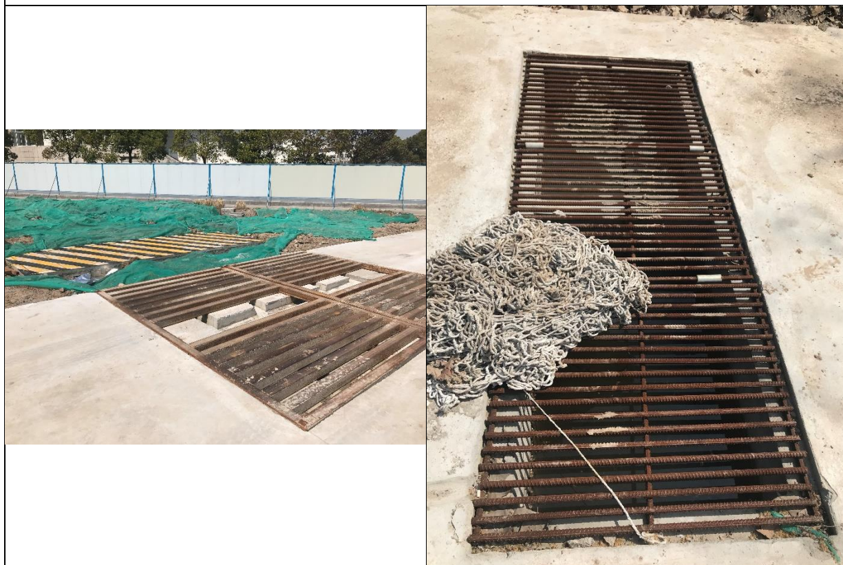
A 地块现场照片
