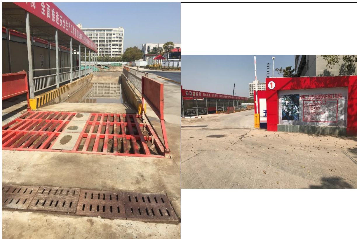
B 地块现场照片
