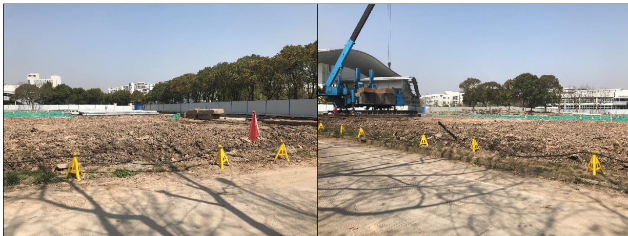
A 地块现场照片
