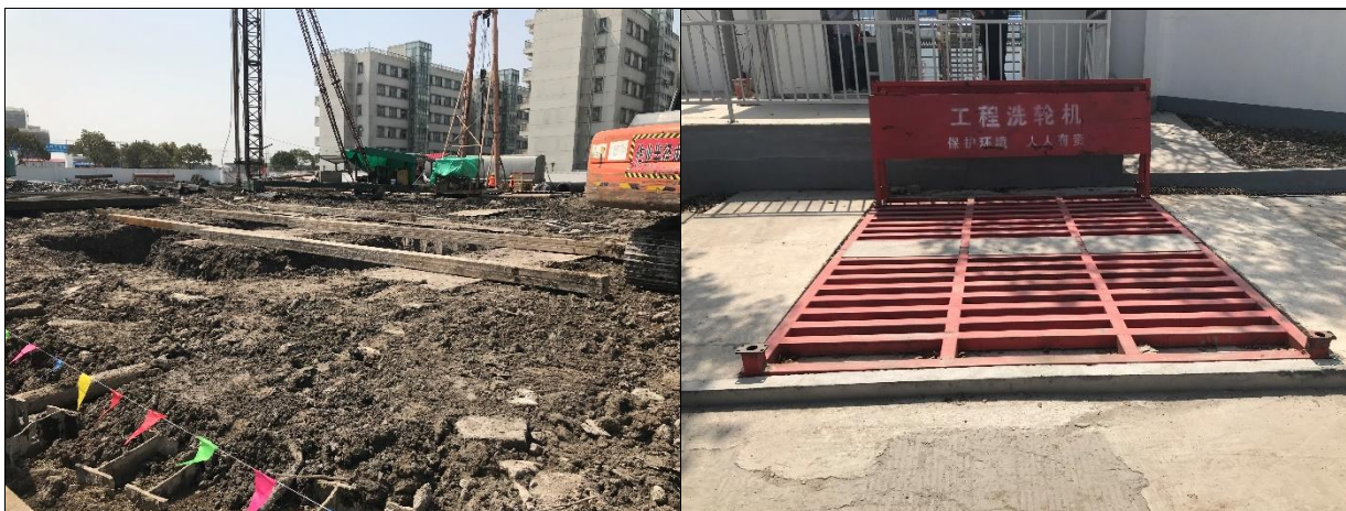
C 地块现场照片
