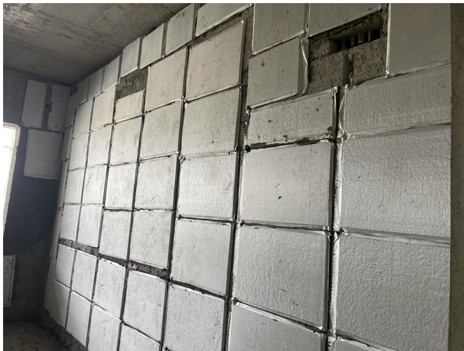
C 区南塔楼八层电梯保温施工
