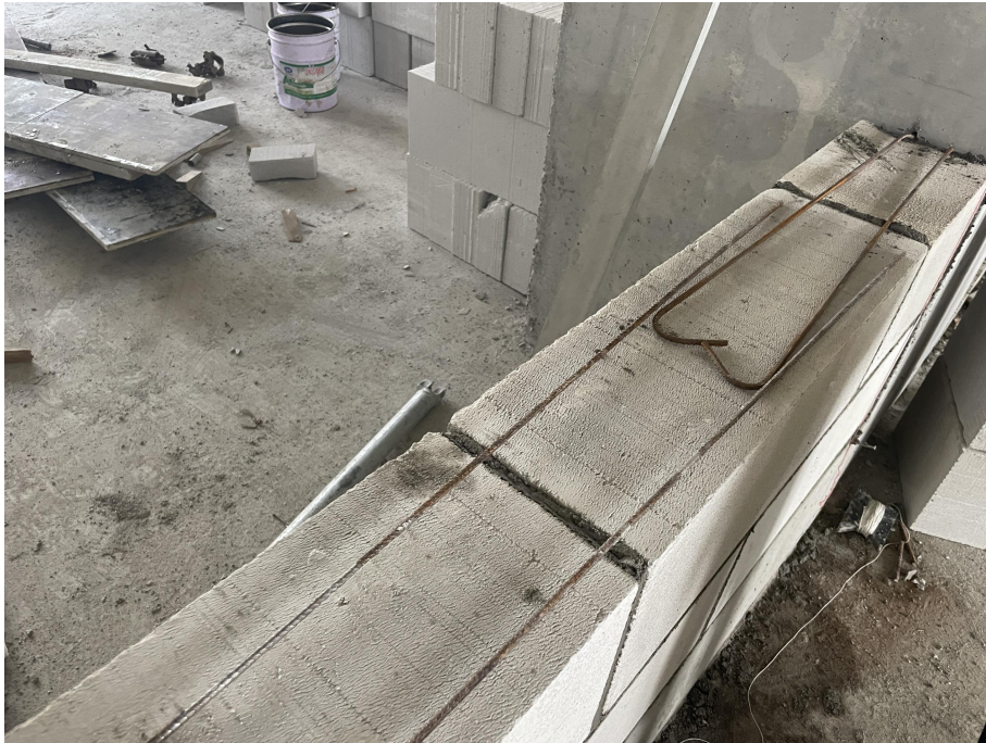
B 区导墙施工
