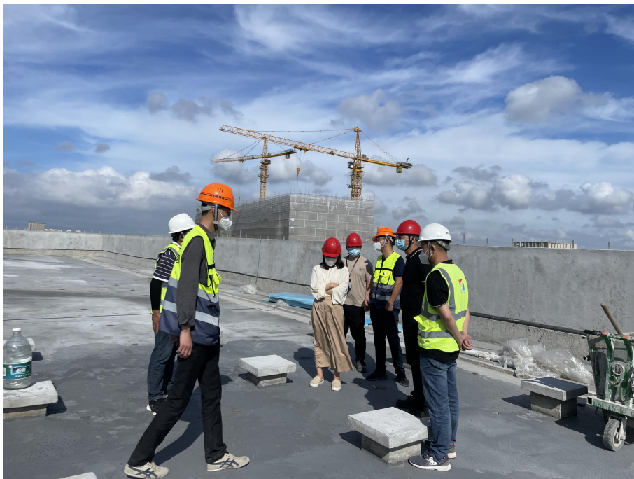
C 区屋面陶粒混凝土找坡检查
