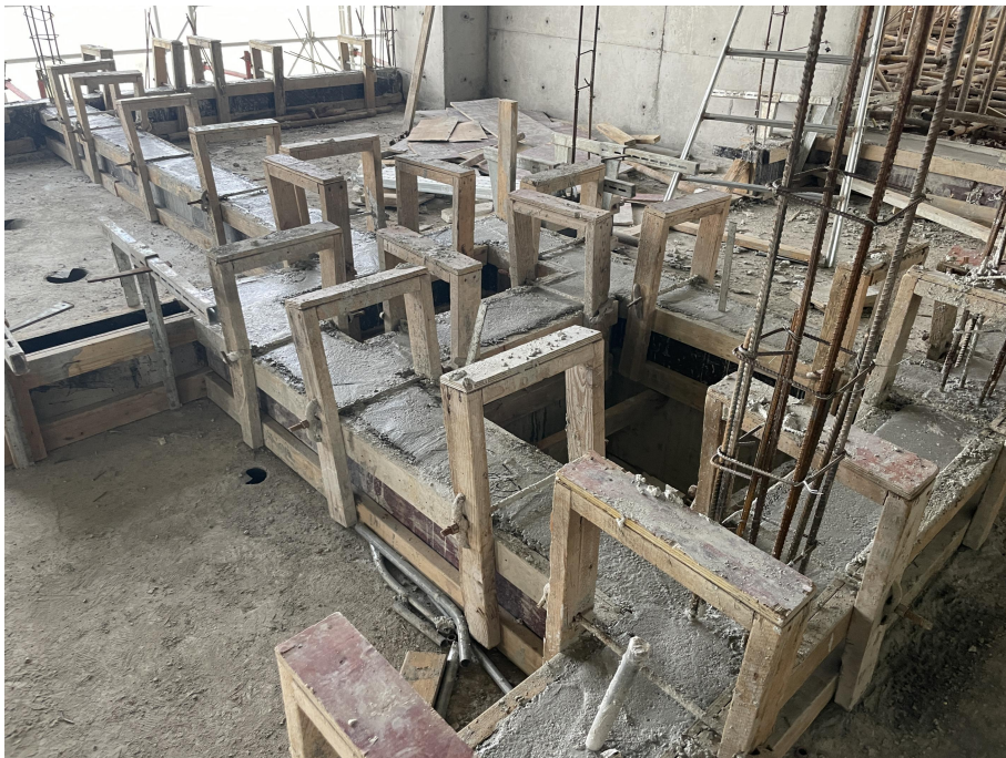
B 区导墙施工
