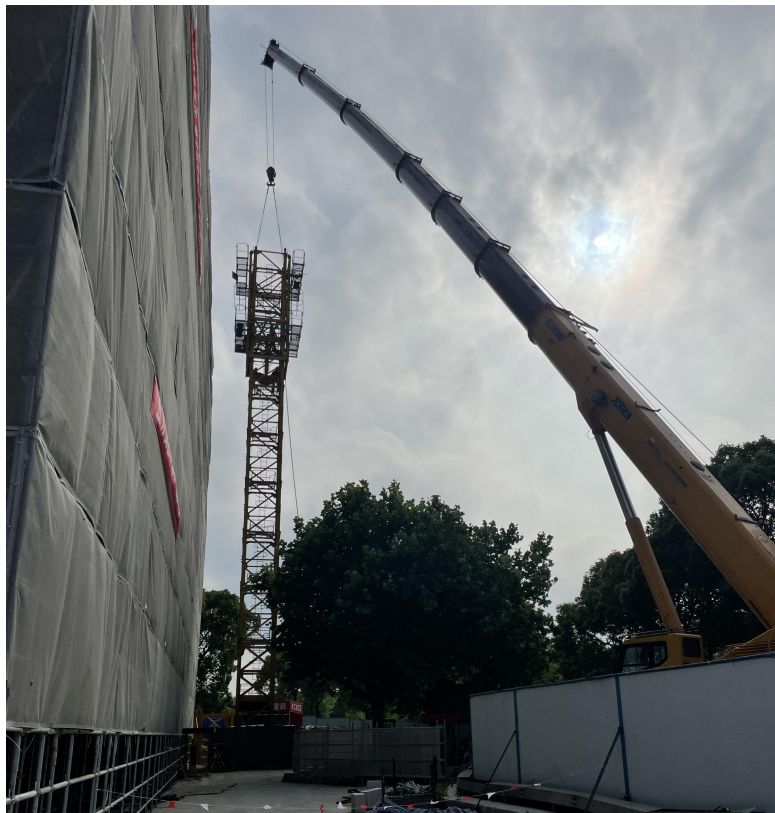
A 区塔吊拆除
